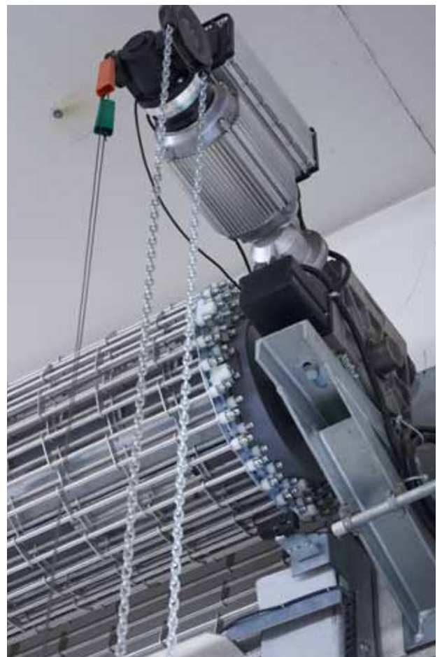
Rolltorwelle und Antrieb mit Nothandkette (optional)
