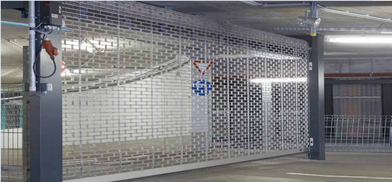
KR 50 als Abtrennung von Parkdecks in einem Parkhaus
