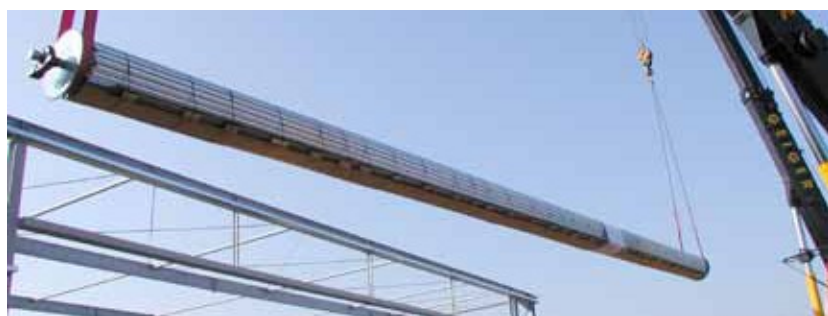
Montage eines K 120
