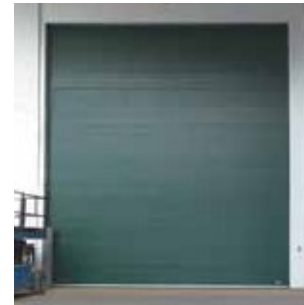
Geschlossene Ausführung mit 80-mm-PUR-Hartschaumpaneelen
